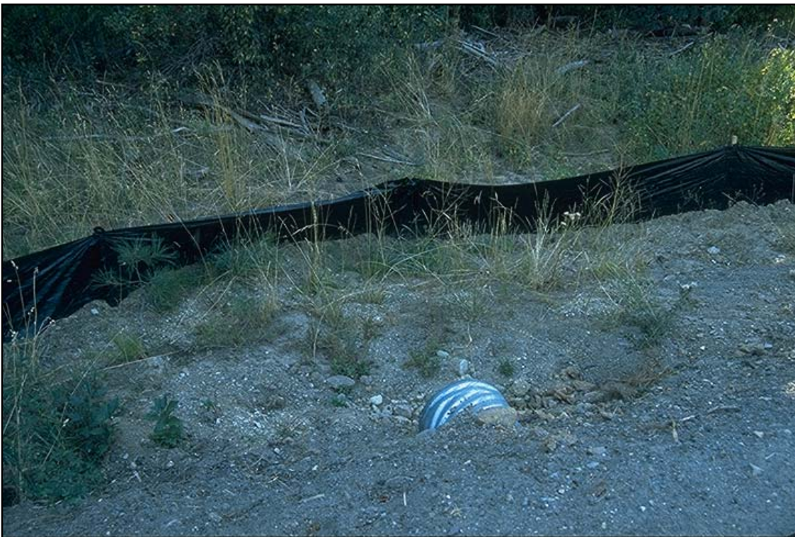
Foto 6.6 Uso de geotextiles como “barreras contra asolves” para atrapar sedimentos de una zona en construcción.
