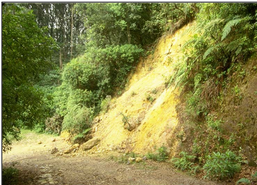
Foto 11.1 Tanto laderas muy abruptas, como zonas inundadas o de deslizamientos, pueden dar lugar a problemas de inestabilidad de un camino y aumentar los costos de reparación y mantenimiento.
