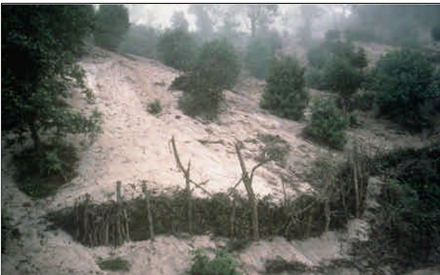
Foto 13.6 Barreras de control de sedimentos, barreras de vegetación viva o barreras de maleza, se pueden usar para controlar el arrastre de sedimentos sobre los taludes (véase también la Foto 6.6).
