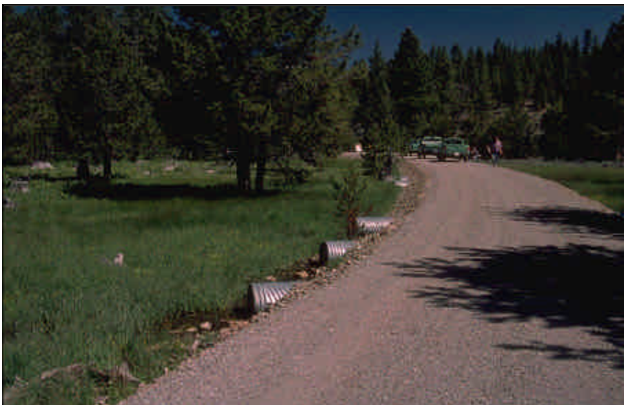
Foto 7.9 Evite el cruce de zonas de praderas inundadas. Si se tiene que cruzar, use tubos múltiples para poder dispersar el flujo de agua a través de la pradera.
