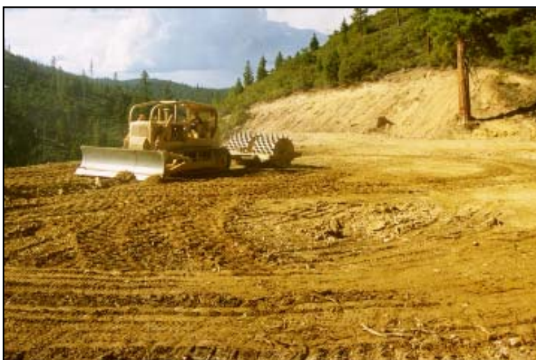
Foto 4.4 Compacte la superficie de la calzada y el material de relleno cuando el camino se localice cerca de arroyos, sobre laderas escarpadas o en zonas con suelos erosionables.
