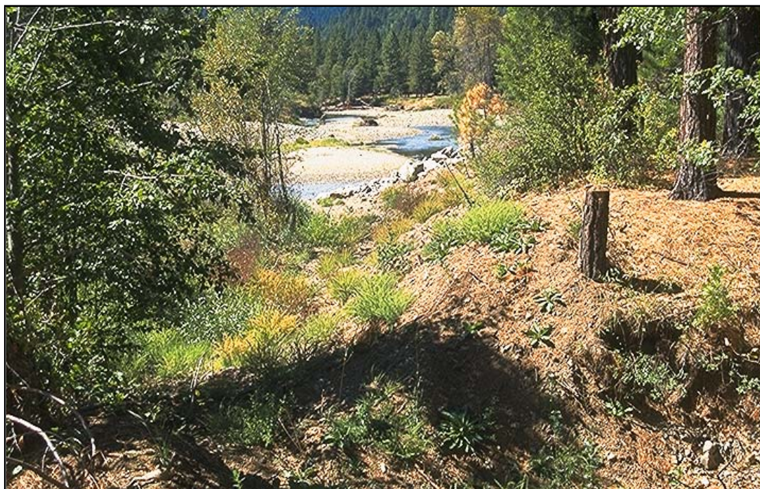
Foto 4.12 Cierre los caminos que ya no se necesiten o que se usaron para acceso temporal. Estabilice la superficie con barreras hidráulicas, bermas y con cobertura vegetal.
