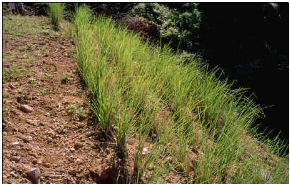
Foto 13.9 Uso de pasto Vetiver para estabilización de taludes y control de la erosión. Seleccione vegetación que se adapte al sitio, que tenga raíces fuertes, y que proporcione una buena cobertura del terreno. De preferencia usar especies nativas.
