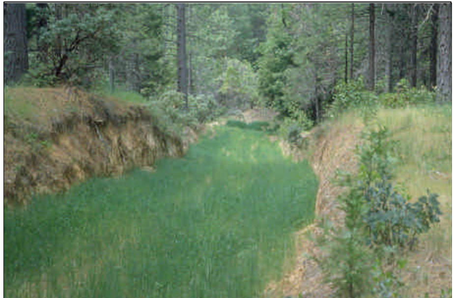
Foto 13.8 Pasto de semilla y cubierta vegetal (capas para protección de semillas y para retención de la humedad) aplicados a la superficie del terreno natural, para promover el crecimiento de pasto sobre zonas desgastadas, caminos cerrados y en suelos erosionables.
