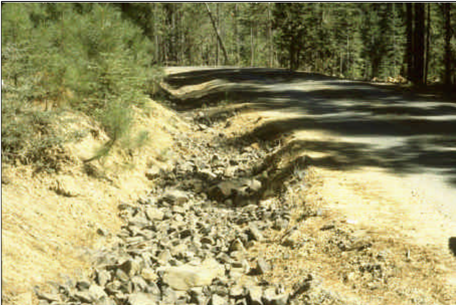
Foto 13.5 Cuneta a un lado del camino, acorazada con rocas bien graduadas para el control de la erosión.
