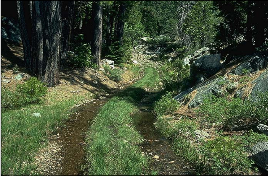
Foto 3.2 Ubicación inadecuada de un camino, el cual se ha convertido en “riachuelo” y está hidrológicamente “conectado” a los arroyos que lo circundan
