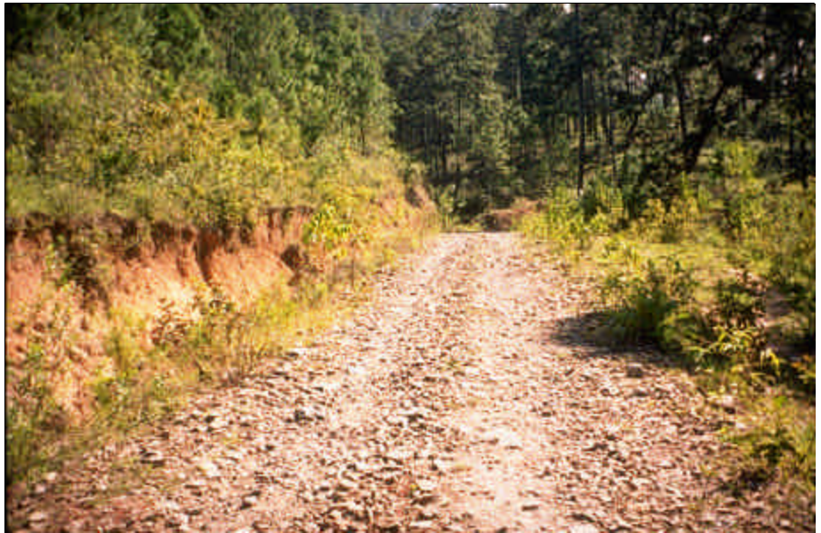
Foto 12.2 Estabilice la superficie de la calzada con roca triturada (o con otro tipo de revestimiento) en gradientes empinados, zonas con suelos blandos o erosionables.
