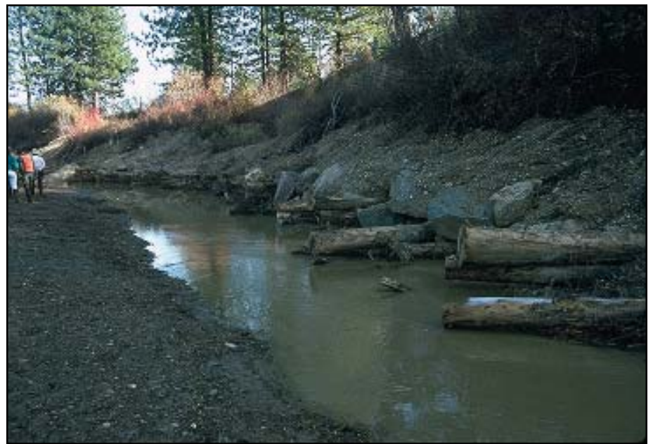
Foto 6.3 Un fajo de raíces, troncos y márgenes del arroyo protegidas con enrocamiento, se usan como protección contra la socavación. Los troncos y vegetación pueden brindar una alternativa atractiva al enrocamiento en zonas del arroyo con velocidades relativamente bajas.
