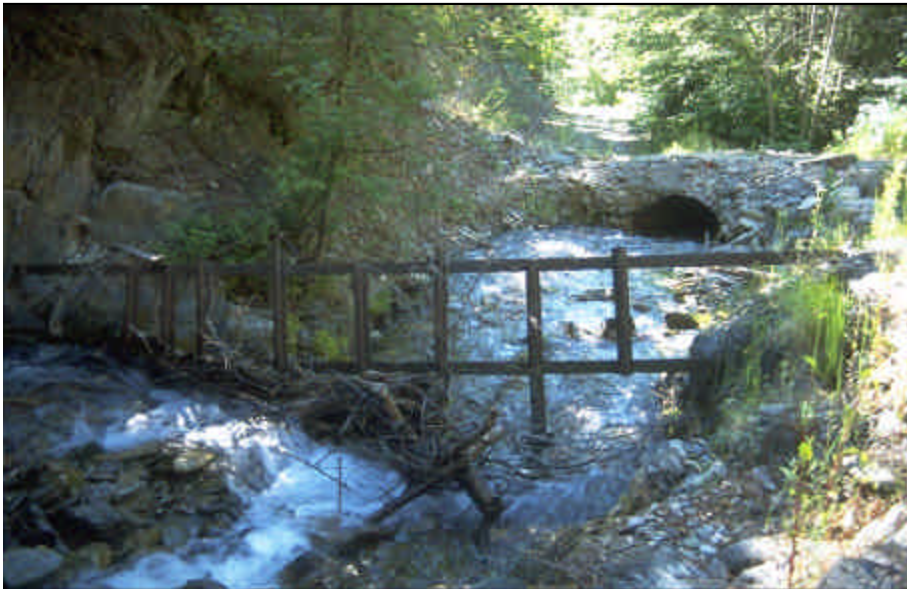
Foto 8.5 Use rejillas en las alcantarillas donde exista la posibilidad de una gran cantidad de escombros en el cauce. Recuerde que las rejillas necesitan limpiarse y darles mantenimiento.
