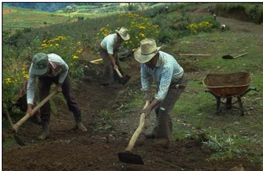
Foto 4.9 Realice el mantenimiento del camino, ya sea con equipo o a mano, para conservar la geometría de la calzada y el funcionamiento correcto de las estructuras de drenaje. Mantenga limpias las cunetas, pero no retire la capa de estabilización vegetal (pasto).
