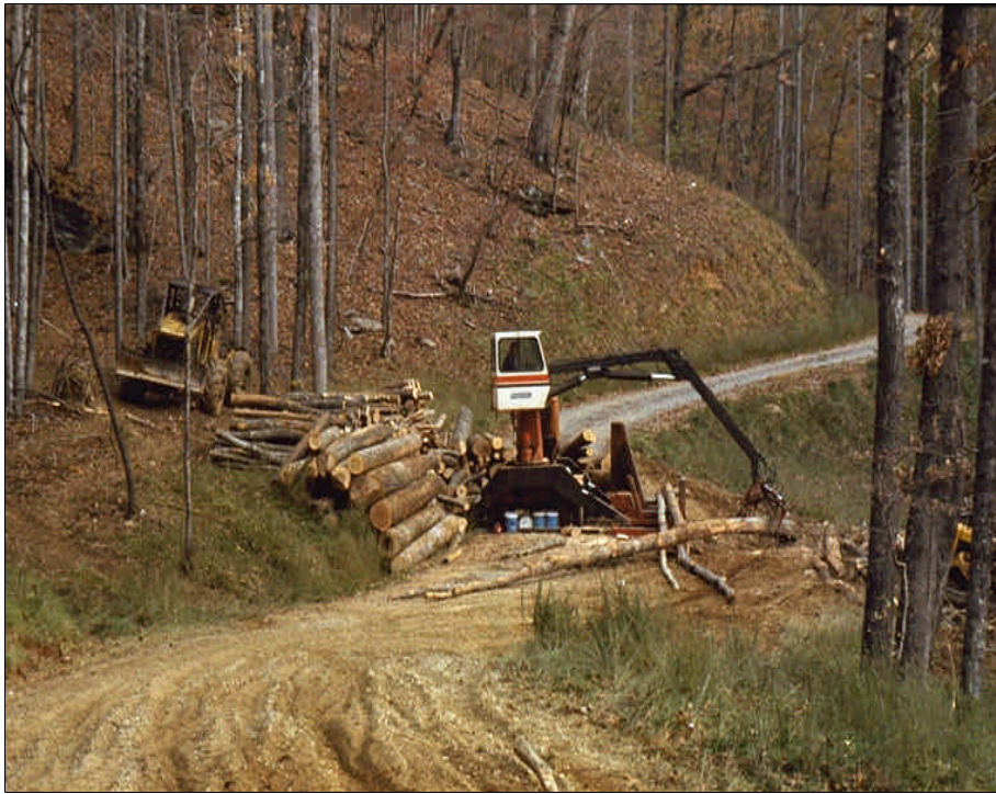
Foto 3.7 Ubique los caminos de arrastre de troncos y las plataformas de carga alejados de la ZPA y de las vías fluviales. Mantenga los caminos y las plataformas de carga pequeños y eficientes.
