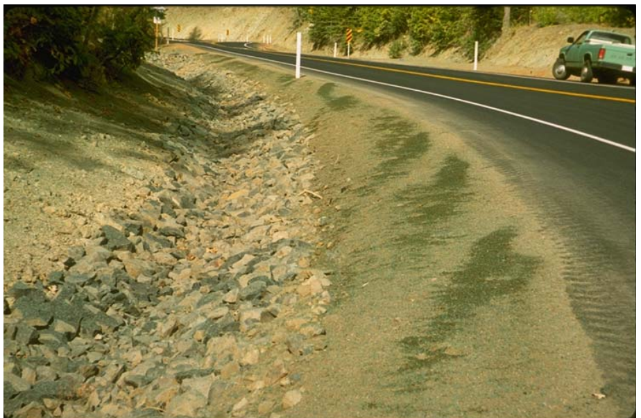
Foto 3.5 Se deberá dar mantenimiento a los caminos y a las obras de drenaje para resistir los efectos de grandes tormentas con una erosión mínima, por ejemplo con enrocamientos de protección en las cunetas, las cuales deben mantenerse limpias.
