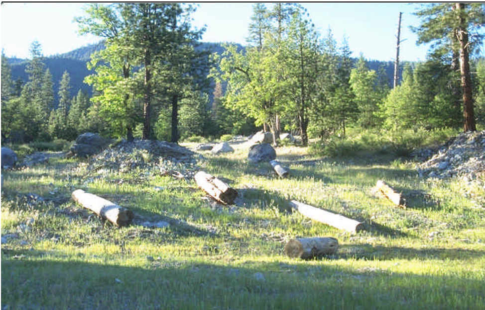
Foto 12.12 Un banco de préstamo que ha sido rehabilitado y reforestado. Reconfigure, drene y restaure los bancos de préstamo y las pedreras, una vez que se han explotado los materiales útiles y el uso de la zona ha terminado.
