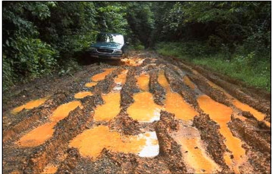
Foto 4.8 Evite las actividades de construcción y de otro tipo durante las temporadas de lluvia siempre que sea posible. Alternativamente, añada estabilización de la superficie y del drenaje en zonas de suelos pobres, para su uso en cualquier tipo de clima.
