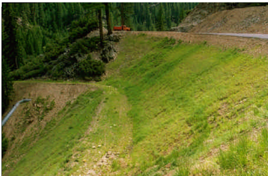
Foto 11.5 Construya los taludes de terraplenes con una inclinación de 1 ½:1 o más tendidos, para promover el crecimiento de la vegetación y estabilizar la superficie.
