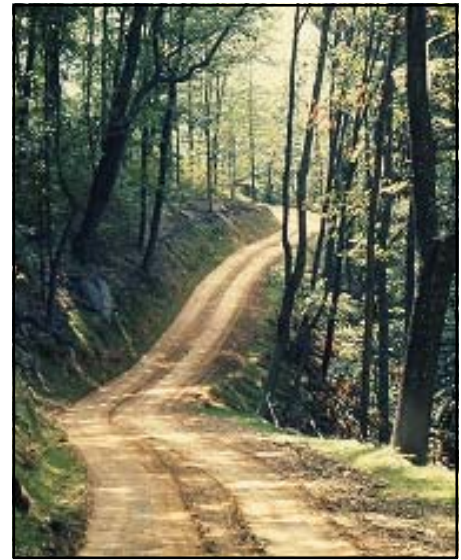
Foto 4.2 Localice los caminos de tal manera que se adapten a la configuración del terreno natural y deje ondulaciones que permitan dispersar el agua frecuentemente. calidad y la inspección , para garantizar que el trabajo se lleva a
