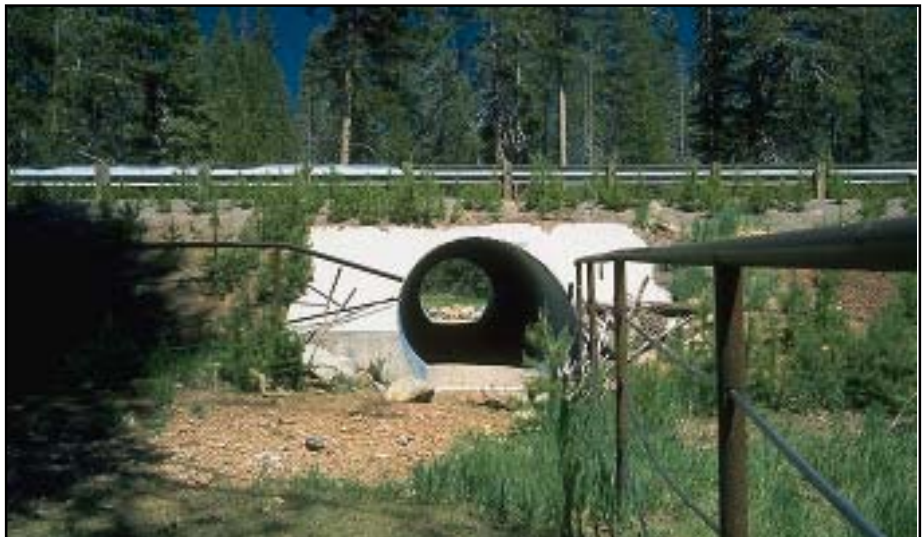
Foto 2.7 Una alcantarilla de paso inferior construida para permitir que los animales se desplacen con seguridad entre ambos lados del camino.
