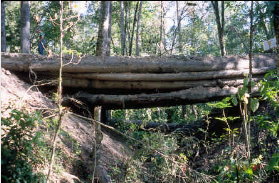
Foto 10.2 La estructura de un puente generalmente proporciona la mayor protección del canal al ubicarse fuera del arroyo. Emplee materiales locales (como pueden ser los troncos) para la construcción de puentes, siempre que estén disponibles, tomando en cuenta la vida útil, costo y mantenimiento. Inspeccione los puentes con regularidad y sustitúyalos cuando ya no resulten estructuralmente adecuados.
