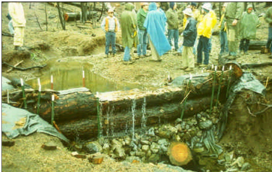
Foto 14.2 Uso de troncos para crear estructuras de estabilización de barranquillas en una área afectada por incendios. Presas físicas o vegetales (diques o estructuras de retención de sedimentos) pueden ser usadas para controlar los sedimentos y estabilizar las barranquillas. Evite la concentración de agua, antes de que se formen las barranquillas.
